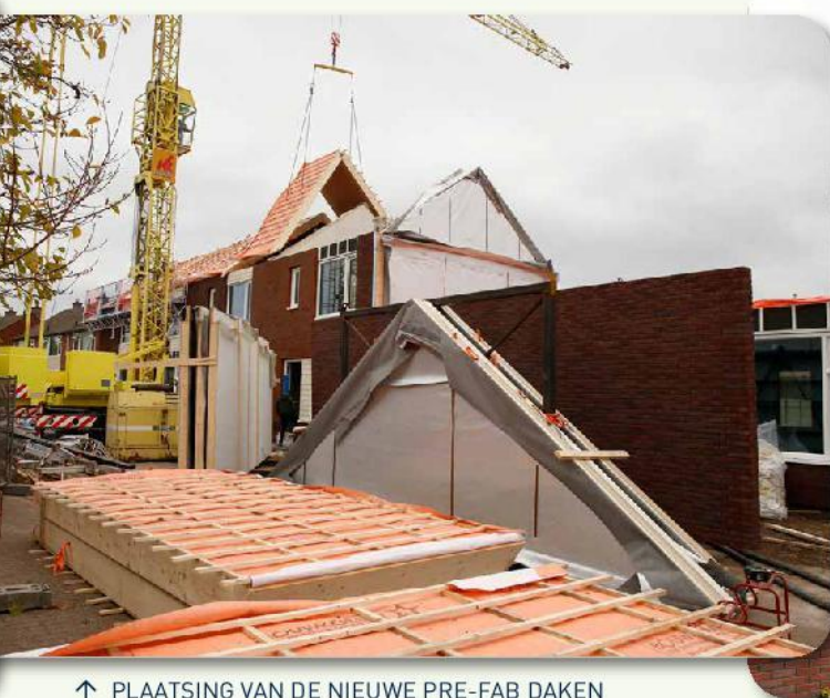
↑ PLAATSING VAN DE NIEUWE PRE-FAB DAKEN
