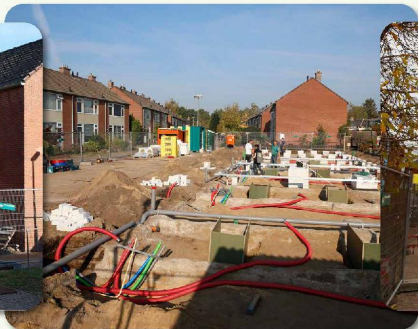
↑ BOUWEN OP DE BESTAANDE FUNDERINGEN
